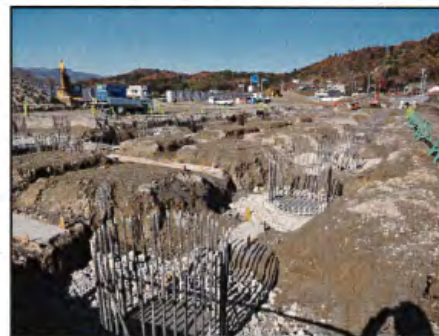
現況写真(全体近景)
