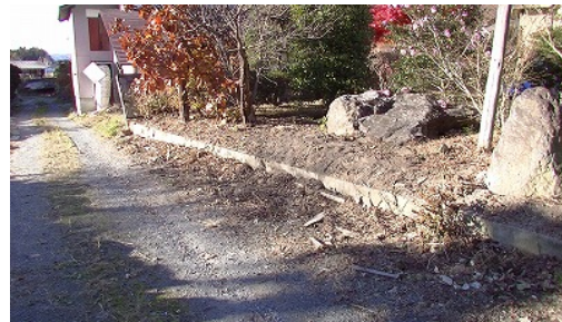
作業後・きれいに撤去
