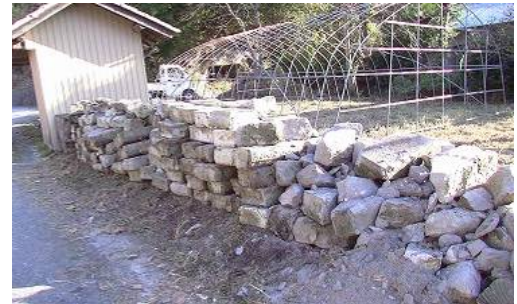
作業後・積重ねられた石垣
