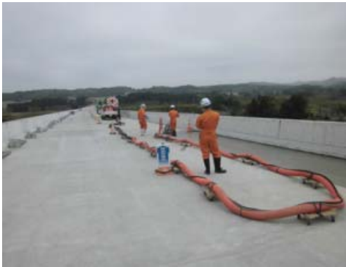
橋梁の除染作業
