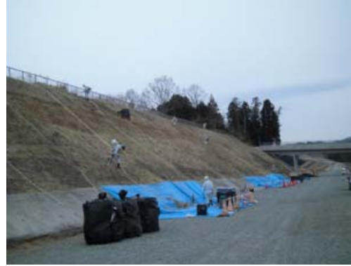
切土部の除染作業
