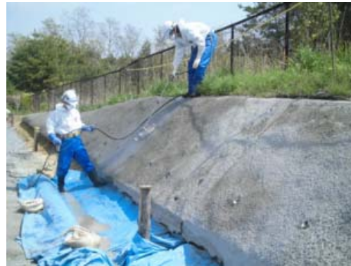
道路法面吹付コンクリートの除染作業
