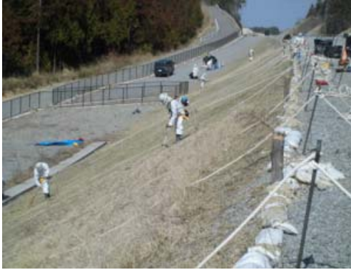
盛土部の除染作業
