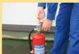
**1** 黄色の安全ピンを垂直方向に引き抜く。
