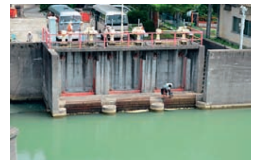
五十嵐川頭首工
