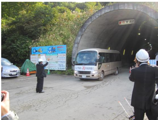
第8号トンネル新潟側坑口車両通過
