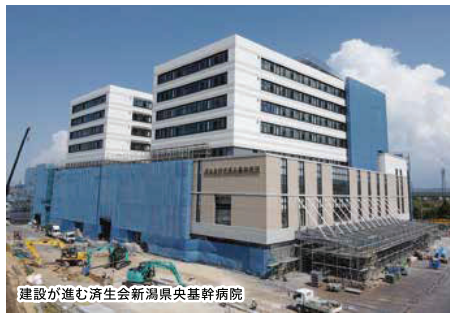
建設が進む済生会新潟県央基幹病院
