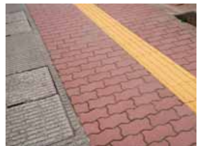
「良寛のみち」の目印となる標識とレンガ色のインターロッキングブロックの舗装
