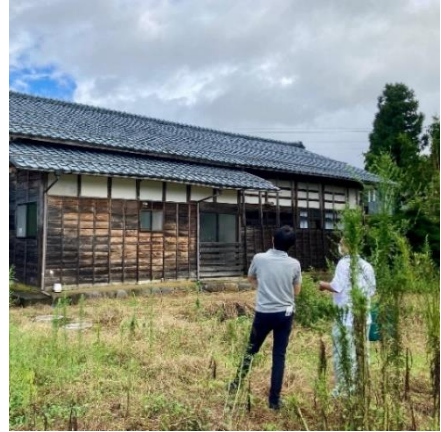
▲空き家の現地確認
