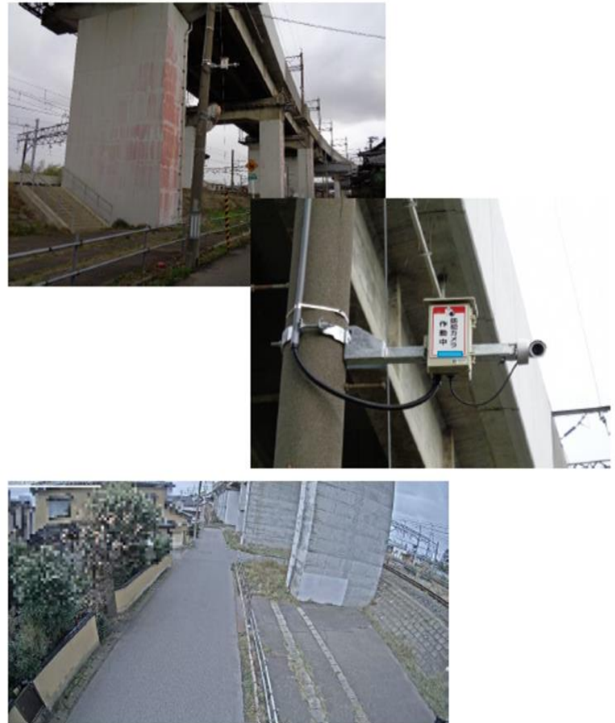
【設置・撮影事例】
