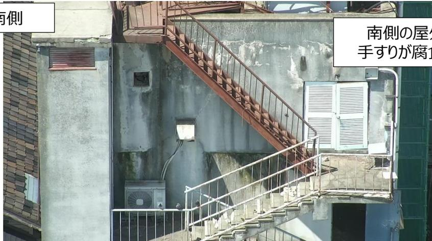
南側の屋外階段の老朽化が進み、手すりが腐食し落下するおそれがある。
