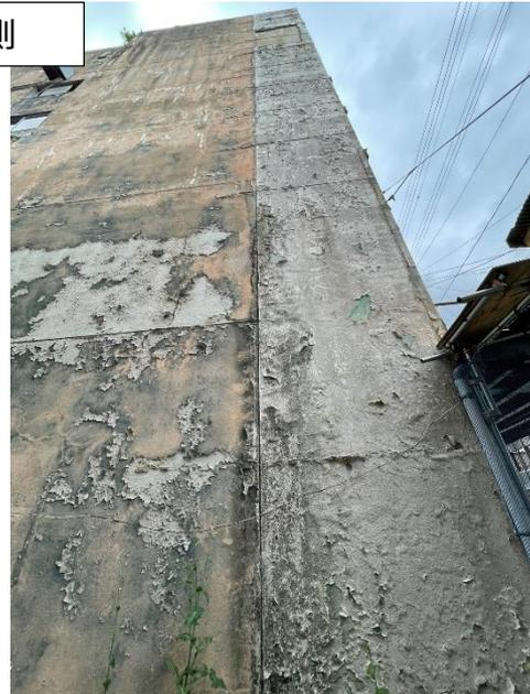
東側の外壁のモルタルに浮きが生じている。
