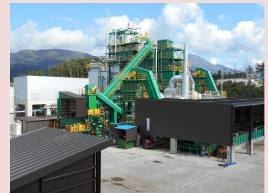
木質バイオマス発電所
