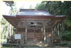
市建3 八木神社本殿・拝殿・幣殿
