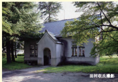
登2・3 三条市水道局大崎浄水場 取水ポンプ場ポンプ室など
