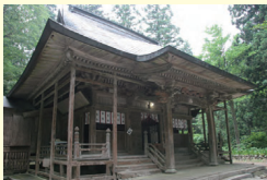
市建4 升賀社古宮、本殿・拝殿・幣殿
