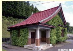
登4～13 三条市水道局大崎浄水場 事務室棟など
