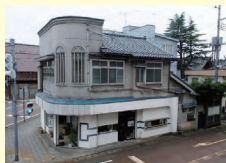
登20 旧外山虎松商店店舗業主屋
