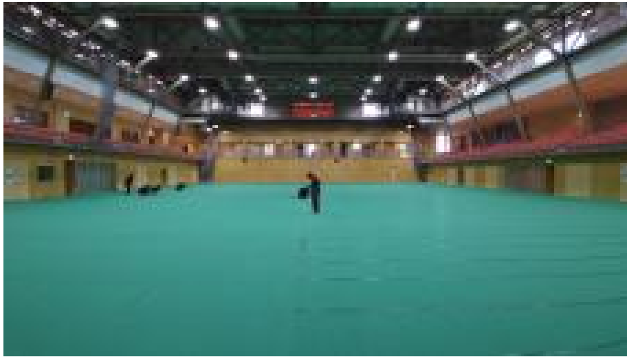
写真① フロアシート（【資材一覧表】17番）をアリーナに設置したところ
