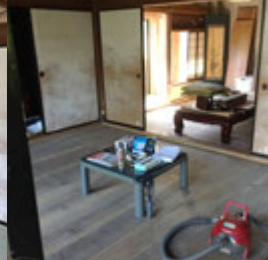
全部剥がした部屋
