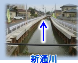
新通川護岸整備状況（大野橋より下流を望む）
