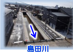
島田川護岸整備状況
