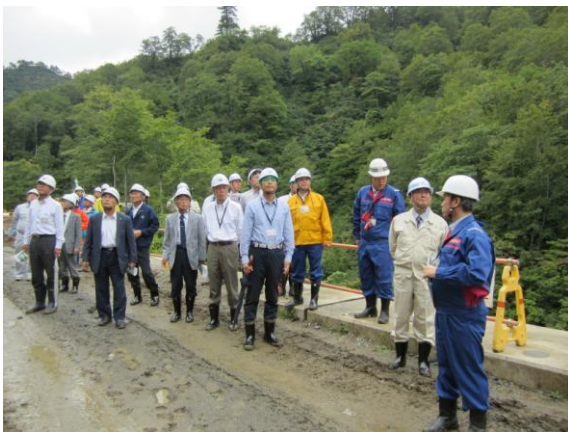
国道289号八十里越福島県側工事現場
